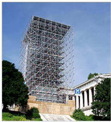
Zur Sanierung eingerüstete Bavaria im August 2002
